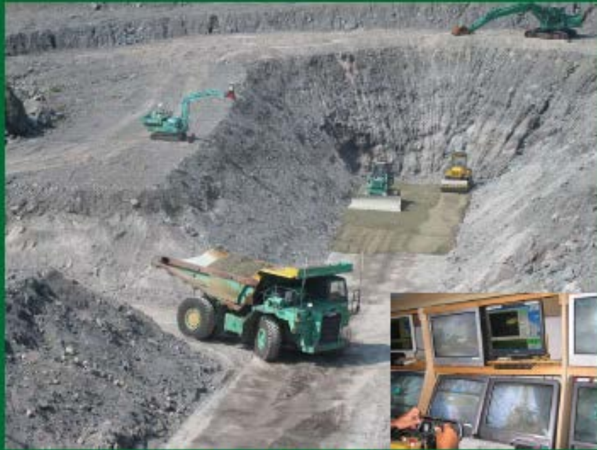
おしが谷砂防えん堤 (RCC 打設) [2009/08]
